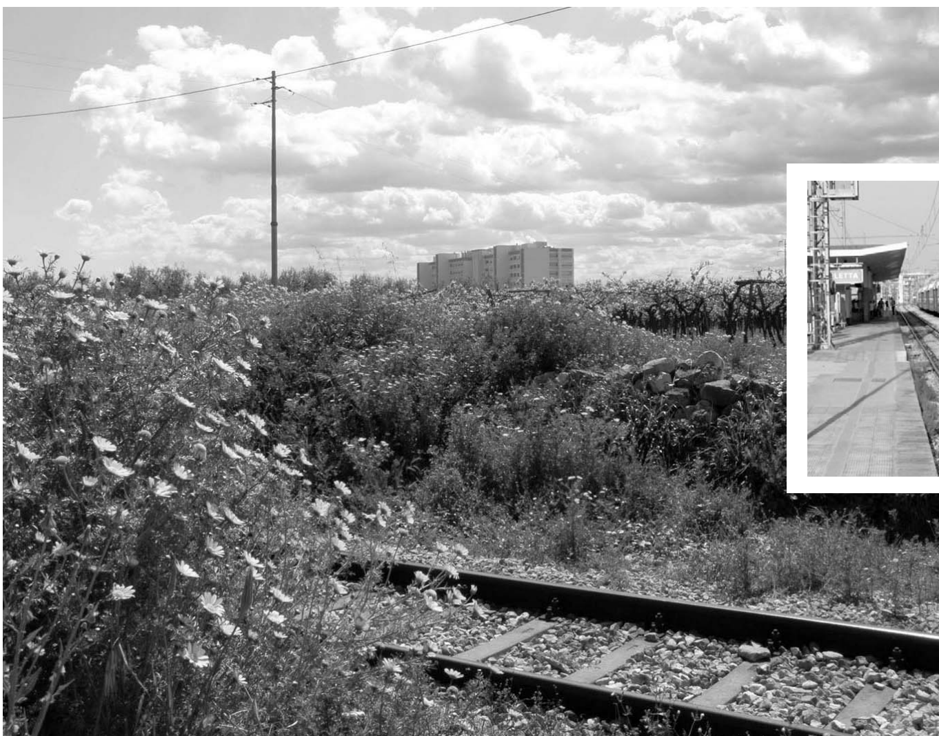
Nei pressi dell'ospedale «Mons. Dimiccoli» sorgerà una fermata della linea ferroviaria Barletta-Spinazzola [foto Calvaresi]
