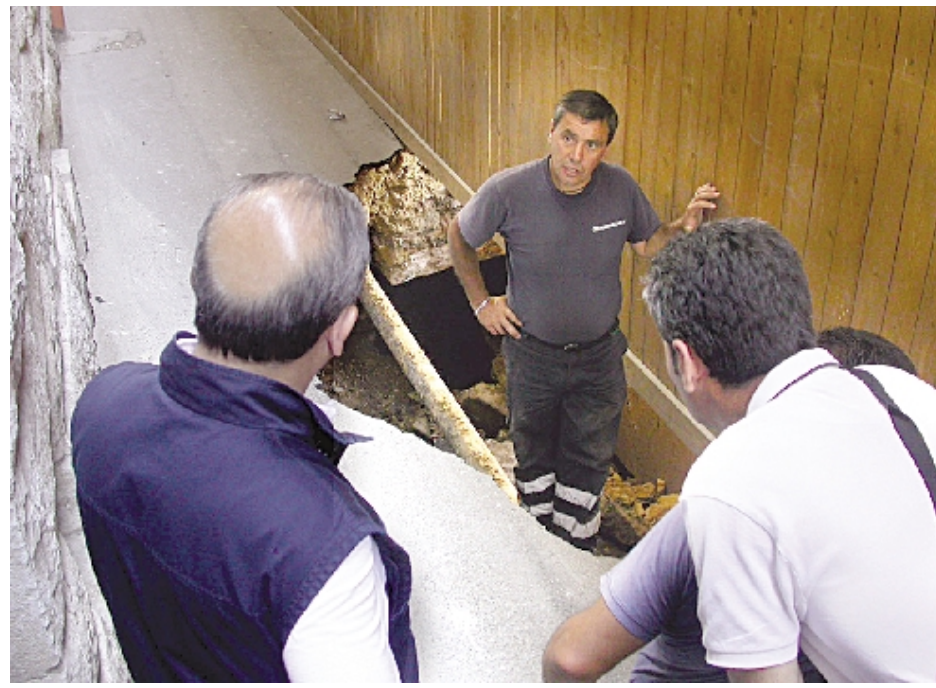
Corato, il sopralluogo sul luogo in cui s'è aperta la voragine
