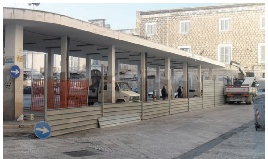
■ I lavori di risistemazione in corso in piazza Campo dei Longobardi
