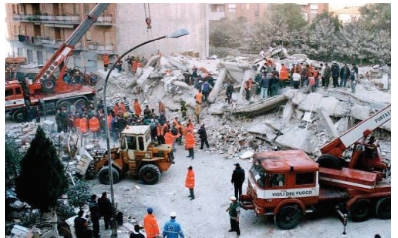
■ Un'immagine del crollo di viale Giotto a Foggia nel novembre 1999
